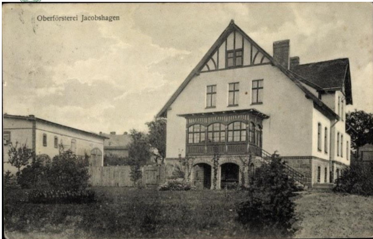
Budynek nadleśnictwa umieszczony na kartce pocztowej. (24.04.1916 r.)
